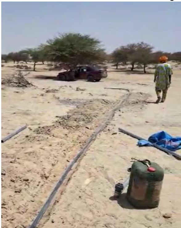
De leidingen voor het irrigatiesysteem worden aangelegd
