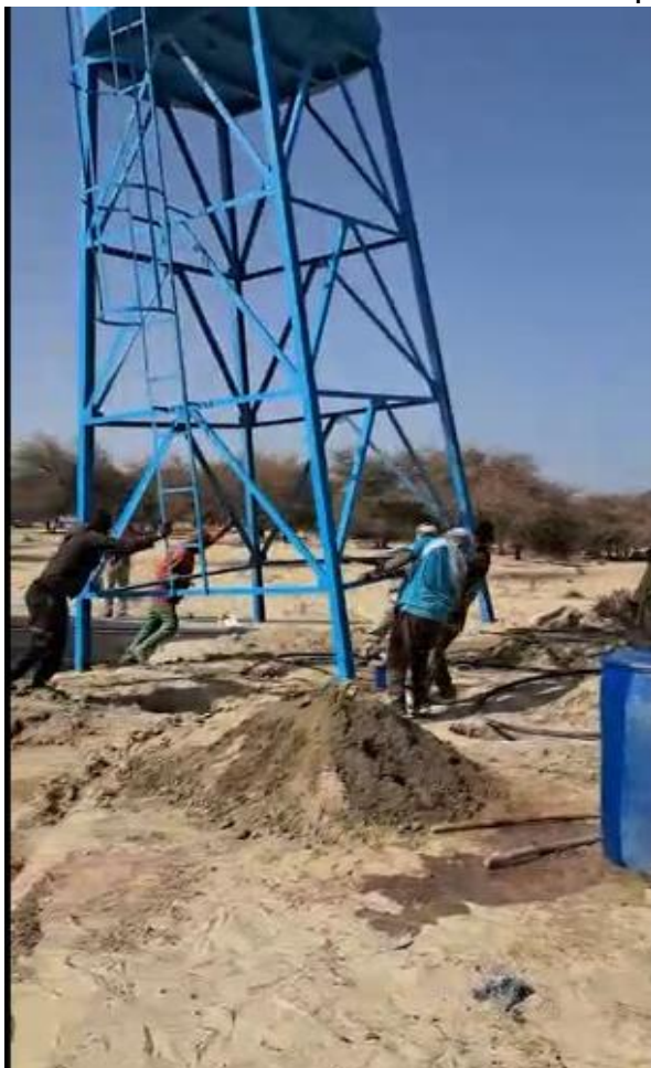
Met man en macht wordt de watertoren op zijn plaats gehesen en geduwd
