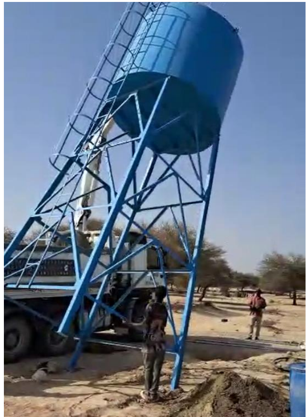
Met man en macht wordt de watertoren op zijn plaats gehesen en geduwd
