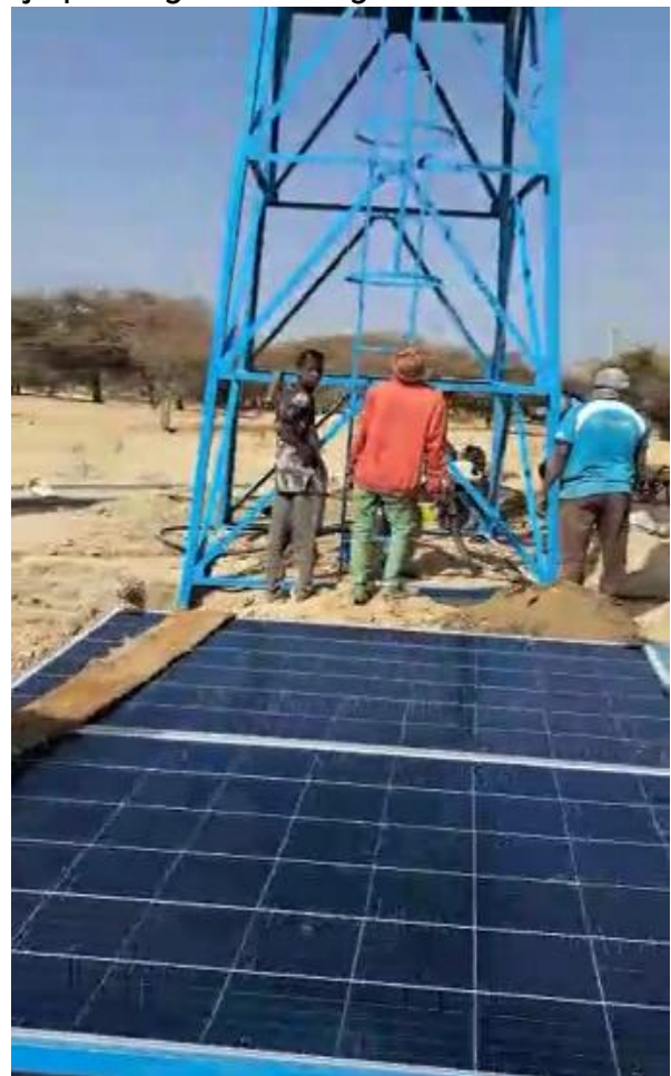
Met man en macht wordt de watertoren op zijn plaats gehesen en geduwd
