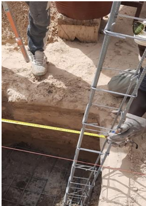
De fundering van de toiletten
